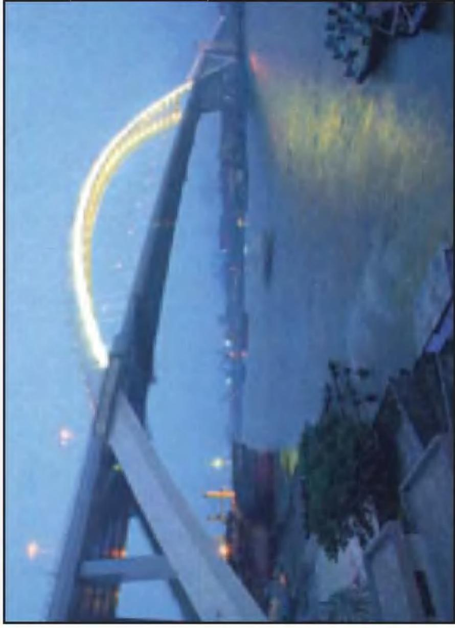
**САМЫЙ БОЛЬШОЙ МОСТ В МИРЕ** построен в Шанхае. Он соединяет берега реки Хуангу и имеет общую длину 3900 м. Причем арка основного пролета моста тянется на 550 м. Общая масса ме-
